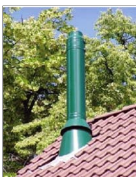
Dachdurchführung mit Blei
